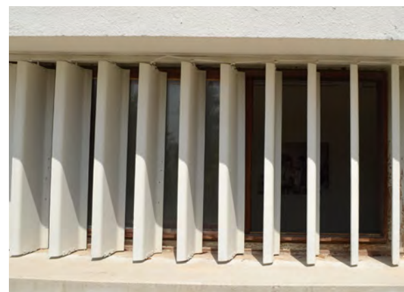
A - אלמנטי הצללה דינמיים - אלמנטים פתוחים - האלמנטים נעים באופן ידני
