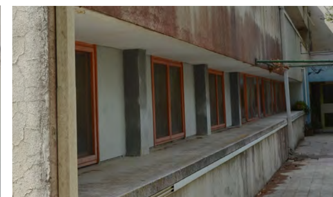
C - חלונות שקועים להצללת החלונות המערביים, בפנים שקיעה זו יוצרת חללי אחסון
