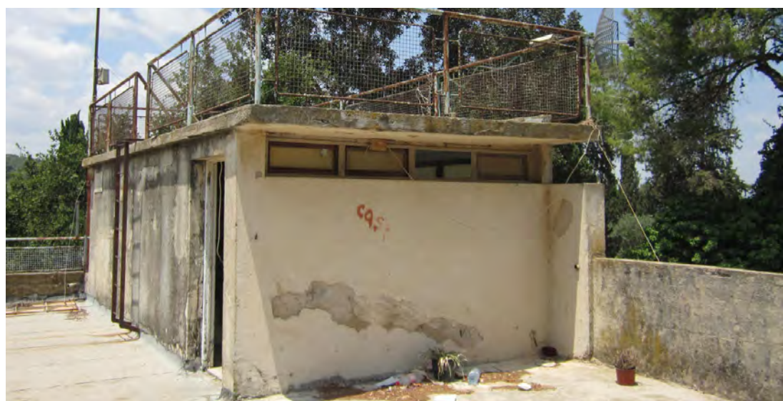
ג2 - חזית מזרחית - מבט אל חדר המדרגות שמוביל לגג, חלונות גבוהים שמאזורים את חדר המדרגות וגורמים לאוויר החם שעולה למעלה לצאת
