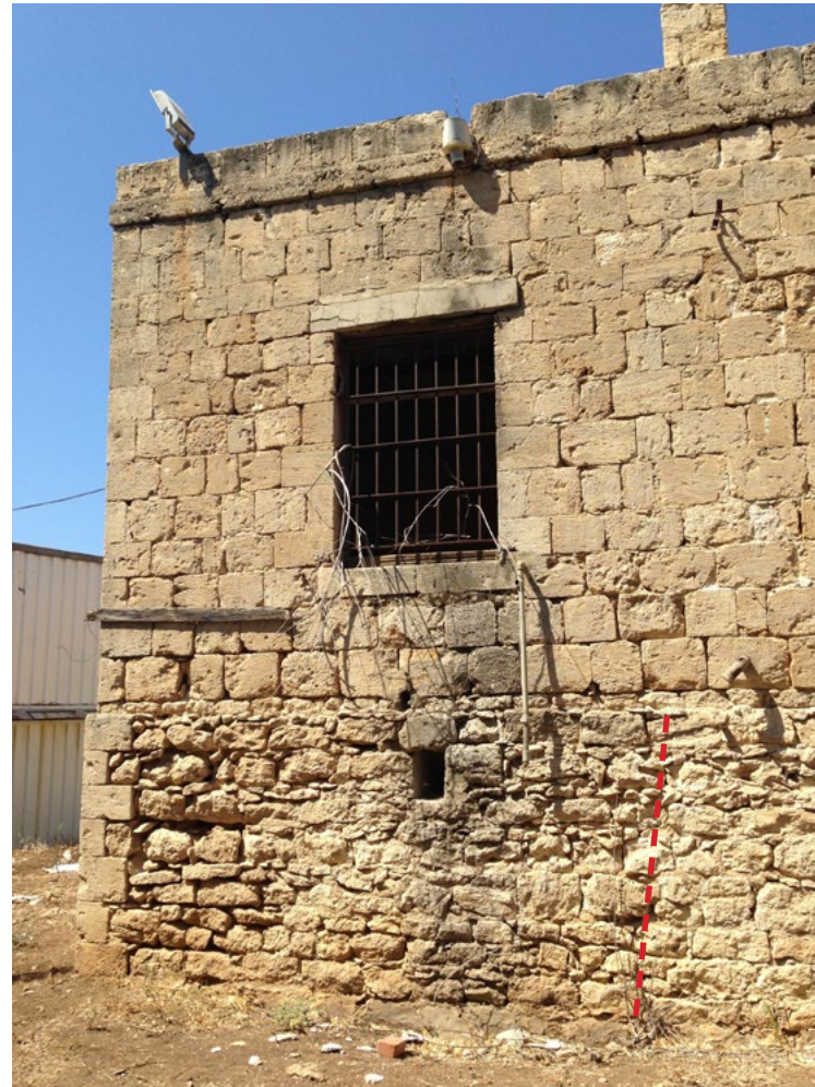
מבט על פתח בור המים בחזית המזרחית, בה נראה בבירור המפגש בין קיר הדבש של קומת המרתף לבין קיר אבני הגזית של הקומה שנייה.
