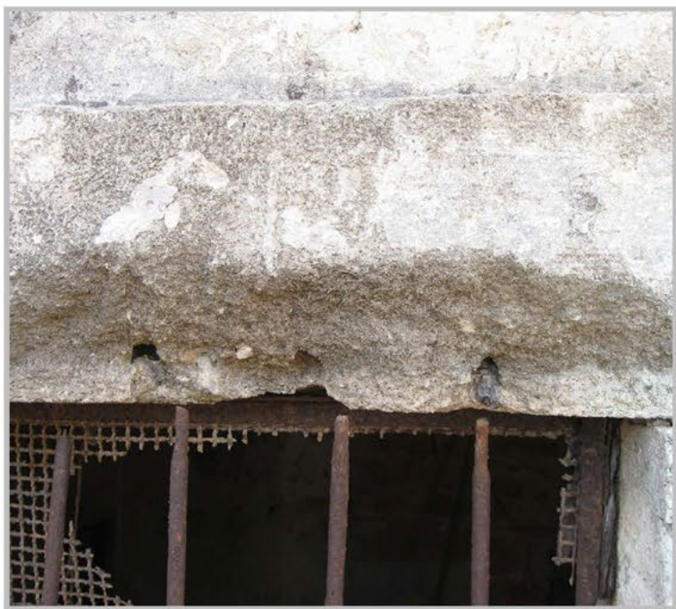
תמונה 2. חזית מערבית. קומה תחתונה. משקוף אבן שבור בשל קורוזיה של הסורגים
