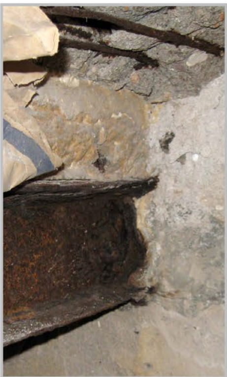
תמונה 4. משטח כניסה. מצב קורת הפלדה נפגע מקורחיה
