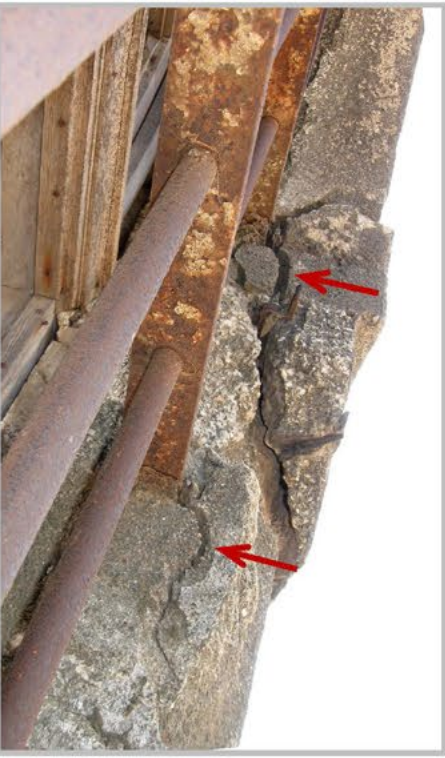
תמונה 7. חזית מערבית. אבני קשת נסדקו בשל קורוזיה של קצוות הסורגים. מצב מסוכן, חלקי האבנים עלולים לפול.
