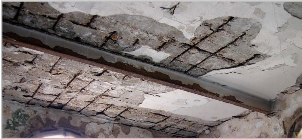
תמונה 1. מבט כללי על התקרה: יציקת בטון מזוין נשענת על קירות המבנה ועל קורת פלדה I 160.
