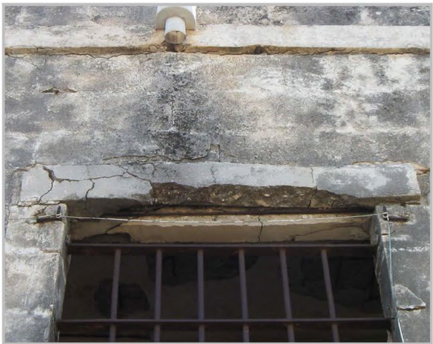
תמונה 3. חזית מערבית. קומה עליונה. הרס של משקוף בטון בשל החלדת מוטות זיון ביציקת הבטון
