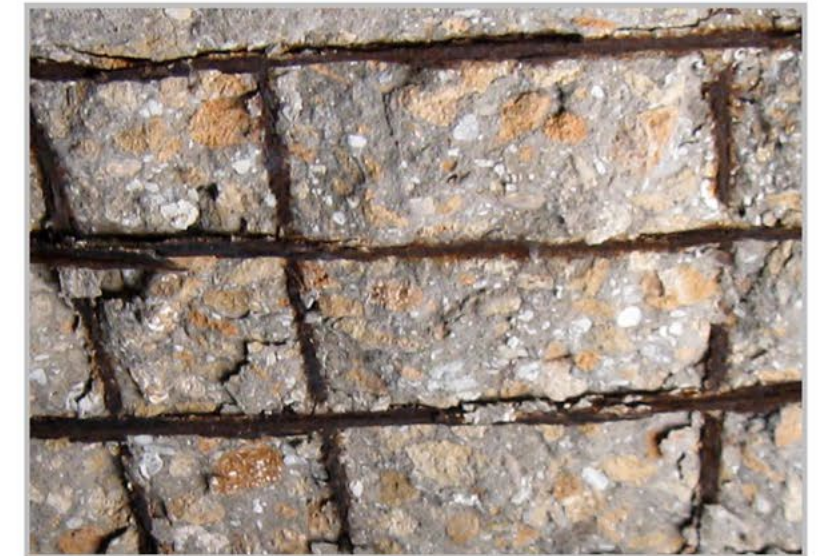
תמונה 3. פרט תקרה – קומת מרתף. מוטות הזיון חלקות, מפוזרות באופן לא מדויק.
