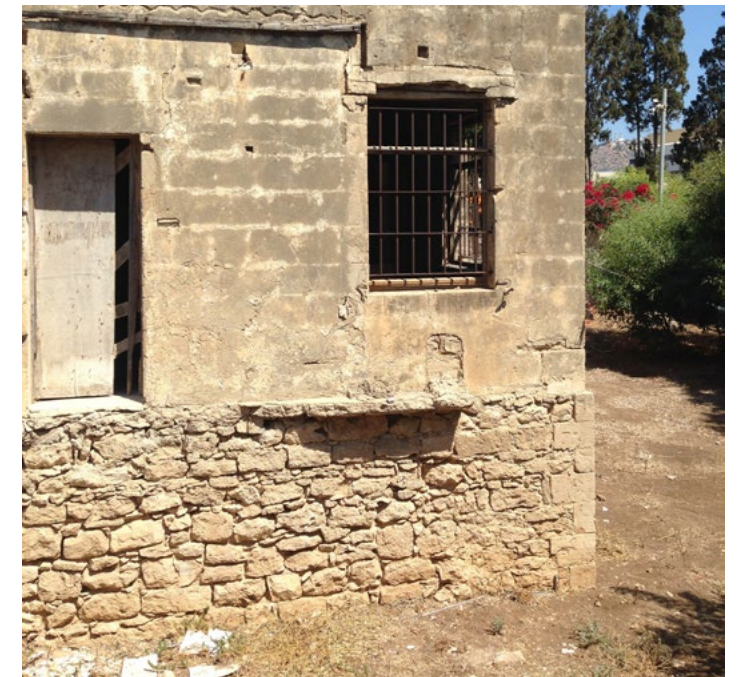
מבט מדרום על הפינה הדרום- מזרחית של הבית, בה נראה בבירור המפגש בין קיר הדבש של קומת המרתף לבין קיר אבני הגזית של הקומה שנייה.
