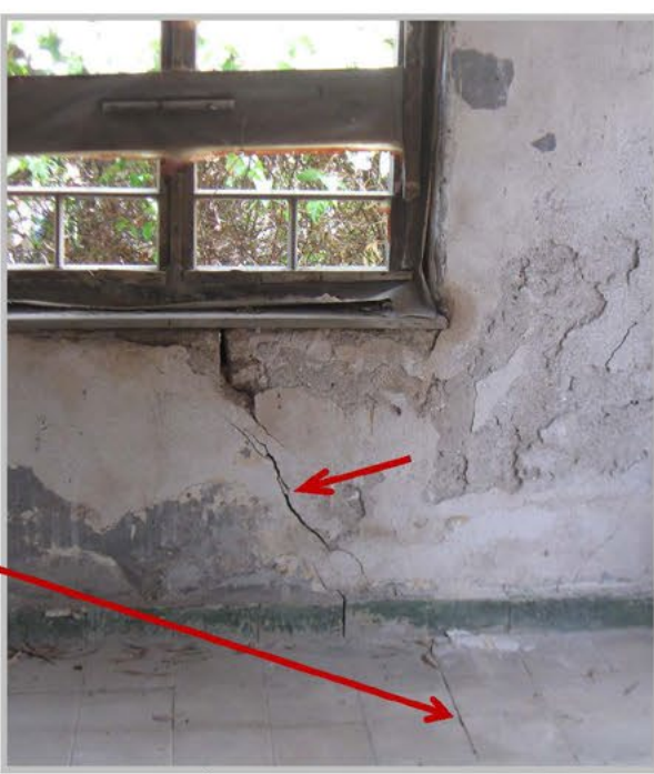
תמונה 2-2. הקורוזיה החמורה של קורת התקרה גורמת לסדיקה בקיר ולהתנפחות וסדק ברצפה.
