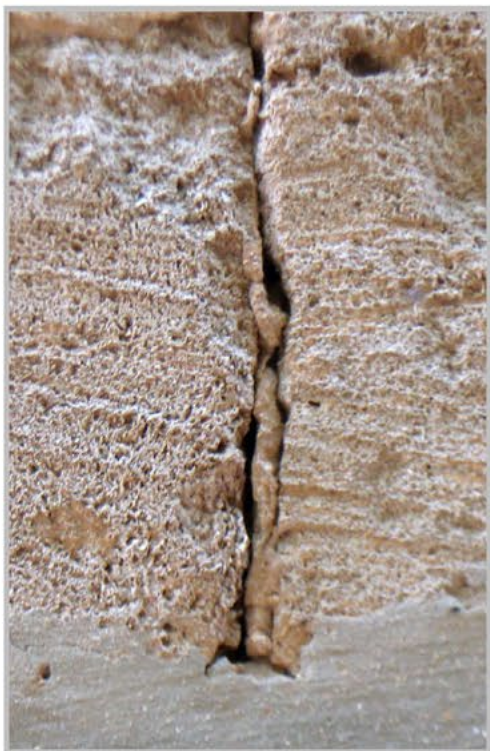
תמונה 3. חומר מתנתק במישק. מי גשמים יכולים לחלחל לתוך הקיר
