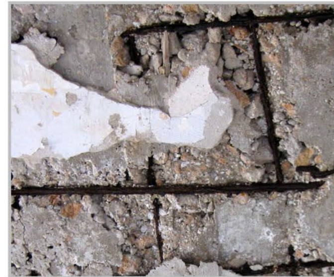
תמונה 2. פרט תקרה – קומת מרתף. מוטות הזיון חלקות, מפוזרות באופן לא מדויק.
