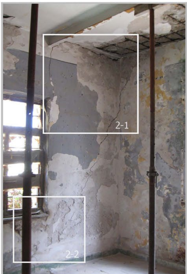
תמונה 2. מערכת סדקים בקיר הצפוני: הסדקים עוברים מקורה של תקרת הגג לקורה של תקרת הביניים ולסדק אופקי במפלס התקרה (ראה בעיה 4), מפינת הבית לקורה של תקרת הביניים.
