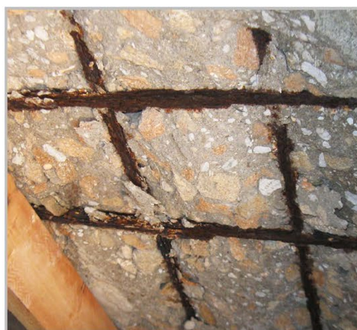
תמונה 4. מצב של תקרות בטון. קורות חמורה של מוטות הפלדה. המוטות איבדו את כושר הנשיאה. שכבת הגנה התקלפה
