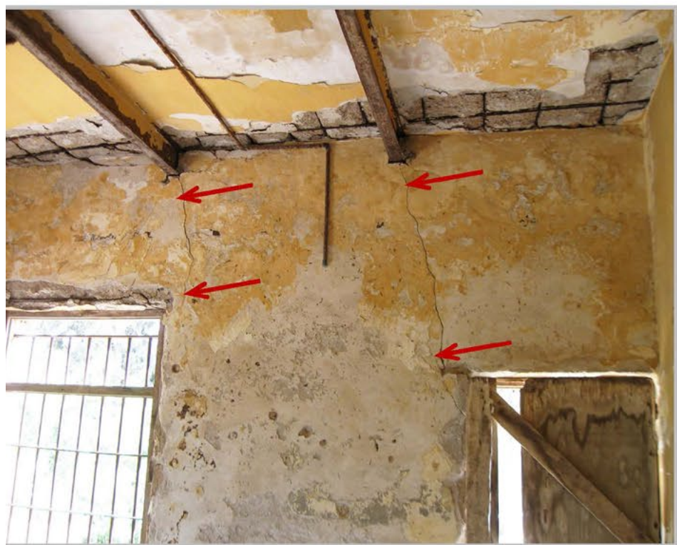
תמונה 1. קיר דרומי, קומה עליונה. הסדקים עוברים מנקודות השענה של קורות התקרה לקצוות משקופי הבטון. החלדת הפלדה גורמת לסדיקה בקיר.
