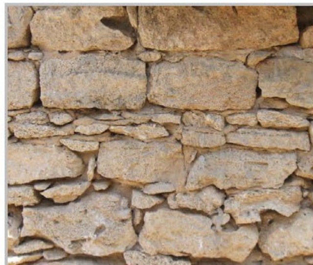
תמונות 3,4. הפינה הצפון מזרחית המחברת בין קיר הדבש לקיר הגזית והפינה הדרום מזרחית המחברת בין קירות הדבש בנויות באופן זהה.
