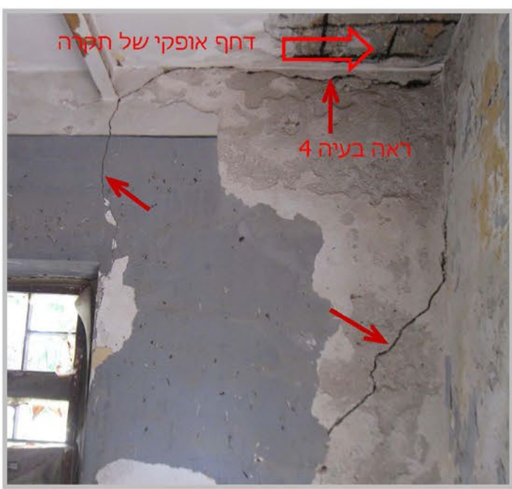
תמונה 2-1. הדחף האופקי של תקרת בטון (הגרם על ידי שינויים תרמיים והחלדת מוטות הפלדה) מחמיר את הסדקים בקיר.
