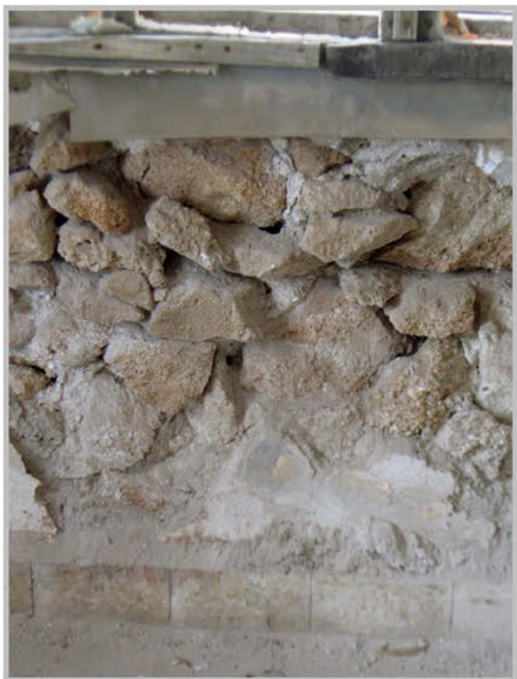
תמונה 4. חומר מליטה התפורר בבניית אבנים קטנות בפן הפנימי של הקירות. אבנים עלולות ליפול
