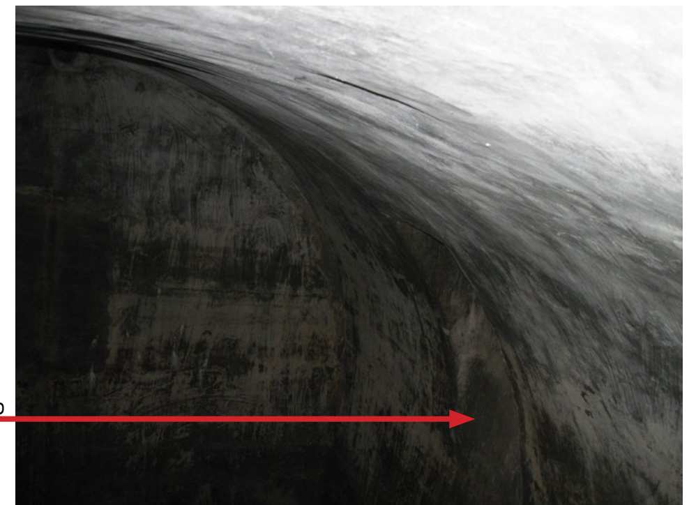
מבט 3: מבט על הפינה הצפון-מערבית של בור המים. בקיר במזרחי של בור המים ניתן לזהות פתח עליון שכפי הנראה נאטם עם ביצוע שינויים במבנה. מעברו השני של הקיר אין עקבות לפתח זה. ייתכן שבמקור שימש כפתח כניסה לניקוז מהגג*. *אין אפשרות להכנס לתוך בור המים - המבטים צולמו מהפתח הקיים בחזית המזרחית.
