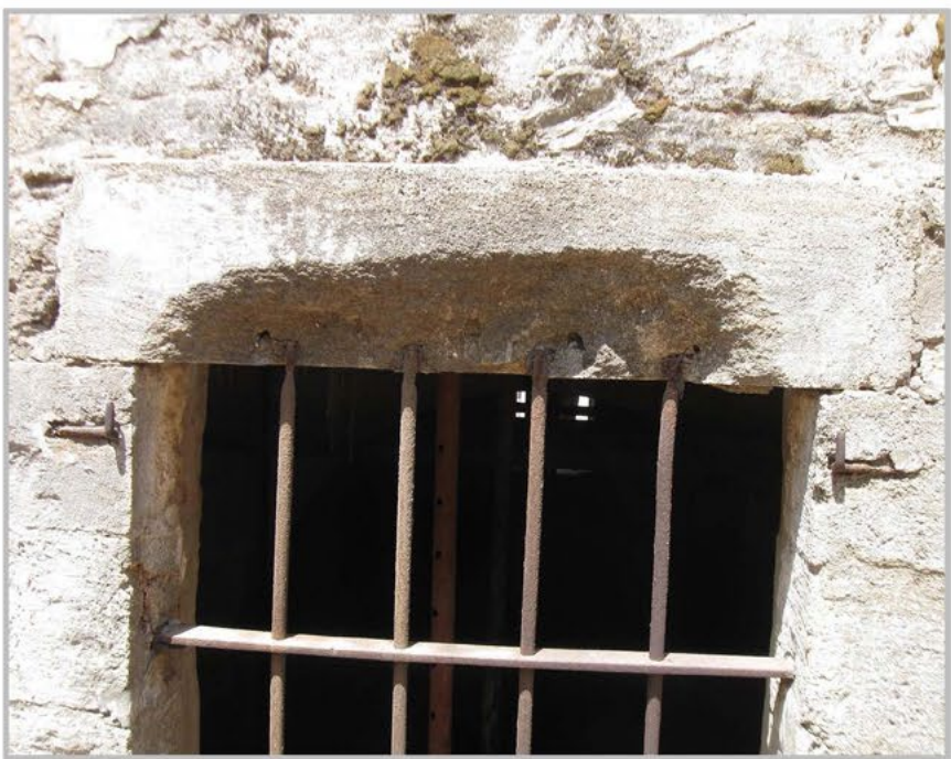
תמונה 1. חזית מזרחית. קומה תחתונה. משקוף אבן שבור בשל קורוזיה של הסורגים
