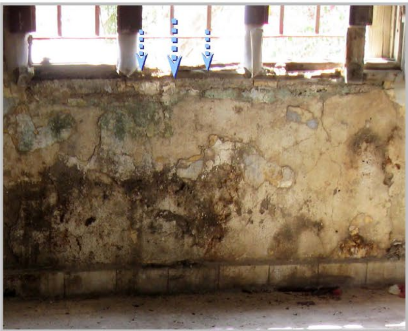
תמונה 1. קומה עליונה. חדר צפון מערבי. רטיבות זיהום ביולוגי בקיר
