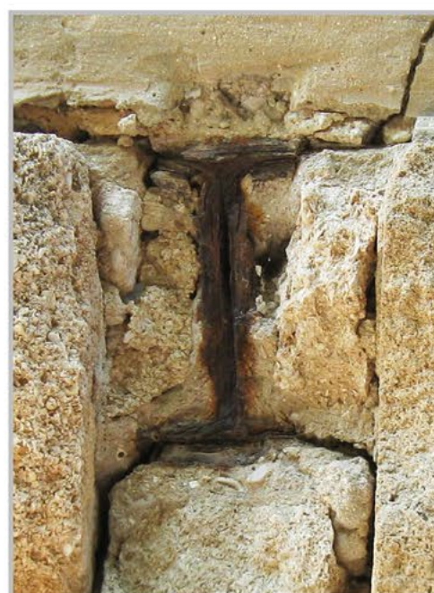
תמונה 1. חזית צפונית, קומה תחתונה. קורות פלדה בתוך הקיר
