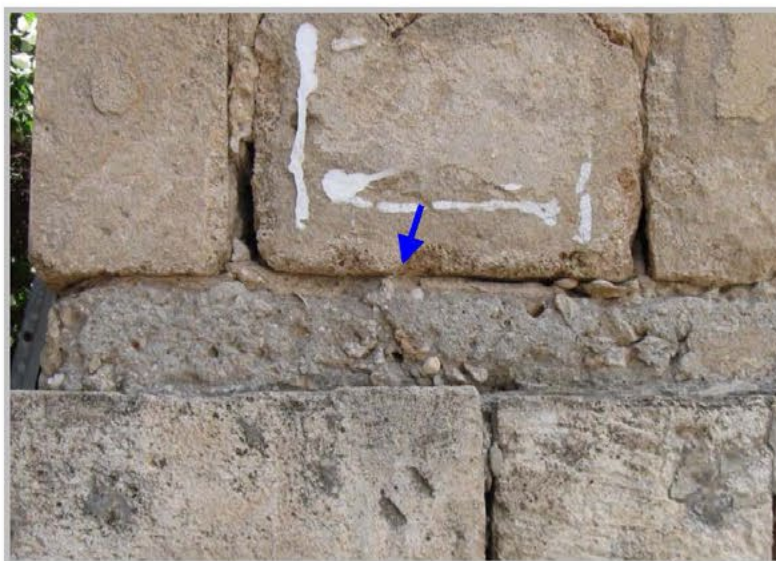
תמונה 5. בניית הקיר של הקומה העליונה בוצע לאחר יציקת תקרת הביניים - ניתן לראות לפי יישום חומר המליטה.
