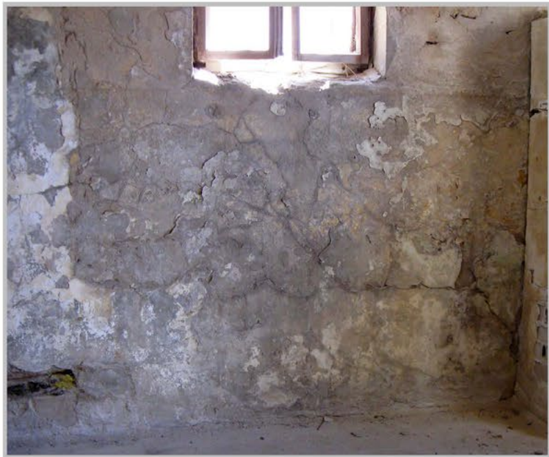
תמונה 1. קיר דרומי. קומה תחתונה. קיר דרומי. סדיקה והתנפחות קלה בקיר.
