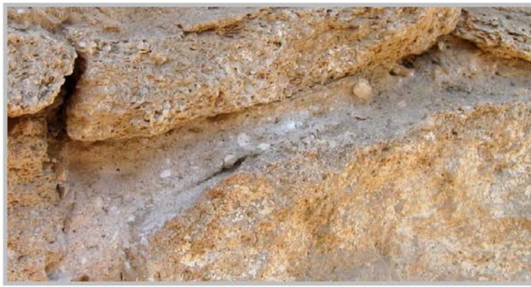
תמונה 2. חומר המליטה כולל גרגרי סיד, תערובת (Hot-mix)
