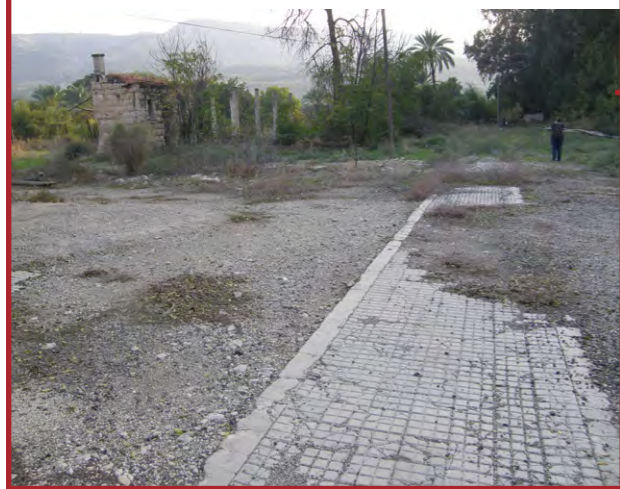
אריחי בטון בהירים בגודל 20*20 המחולקים לתת גריד של רשת קטנה יותר אשר שימשו את משטח הריצוף של רציף הרכבת
