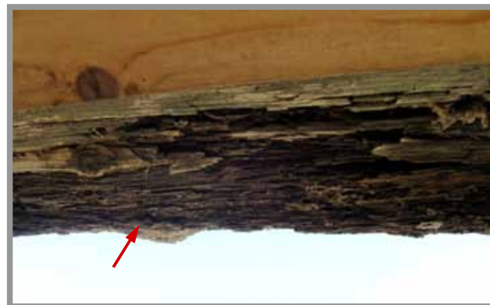
בעיה 13. מפלס D, קורת המשקוף נרקבה. מבט מהחלל הפנימי.
