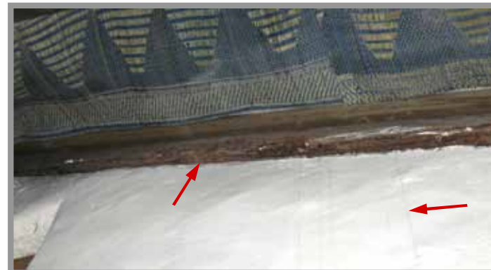
בעיה 12. מפלס D, מאוורלטה (קורת האורך על ראש הקיר) נפגעה קשות מריקבון.
