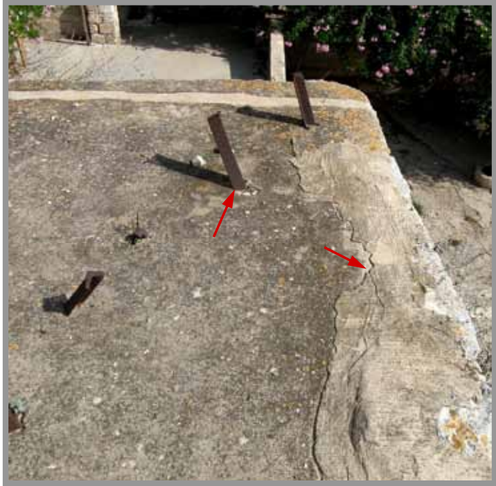
גג מפלס B. תיקונים מאוחרים בבטון נסדק, פגיעה באיטום הגג בחלקי פלדה שהחלידו
