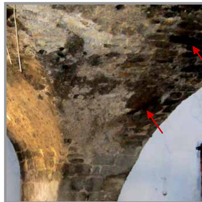
קמרון במפלס C. רטיבות גבוהה מאוד, עובש על פני הקמרון.
