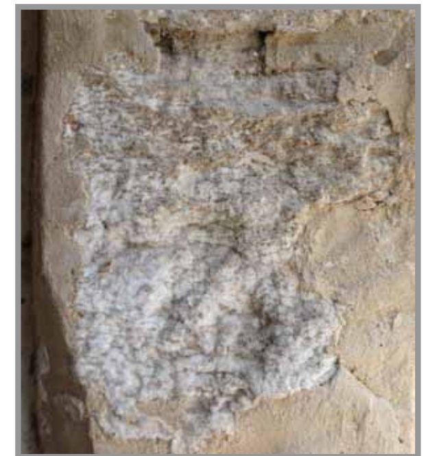
מפלס A. ציפוי בטון על כל פני הקמרון והקירות
