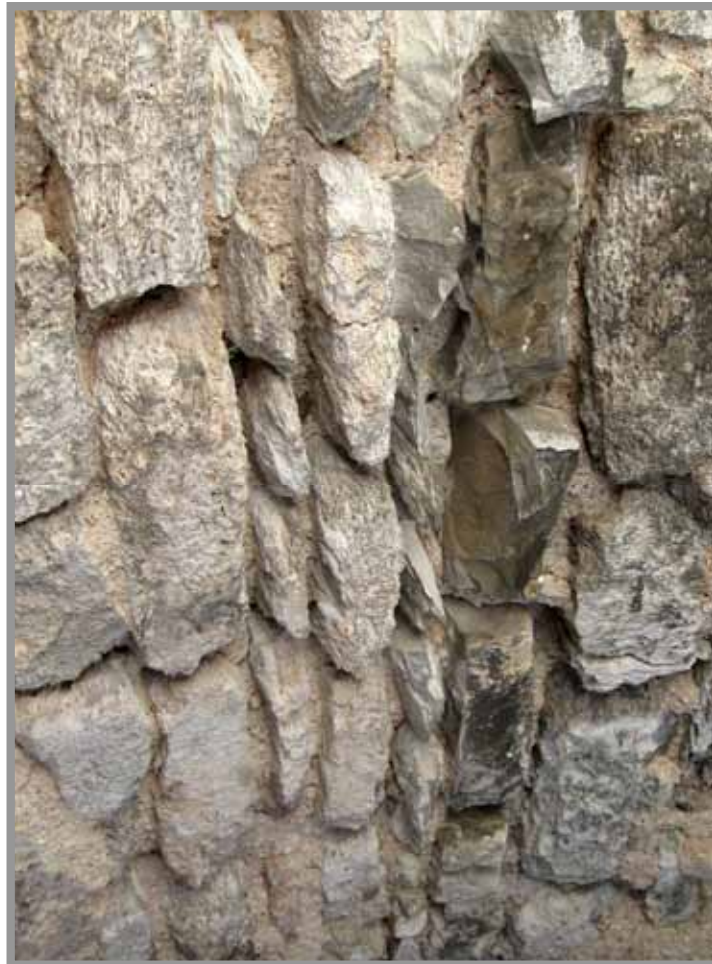
בעיה 9א. מפלס הכוכים, הכוך המזרחי. מישקים ריקים בקמרון, הדבר עלול לפגוע ביציבות הקמרון.
