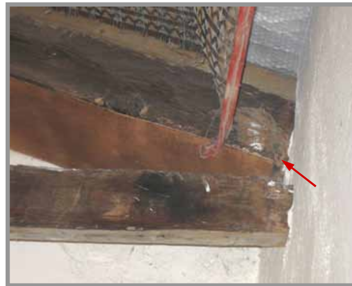
בעיה 12. מפלס D, קונסטרוקציה של גג. העץ נרקב באזור השענת הקורות על הקיר
