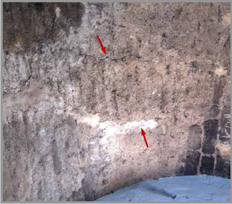
בעיה 2. מפלס C. סדקים בקמרון צלב נמשכים לכל אורך הקמרון
