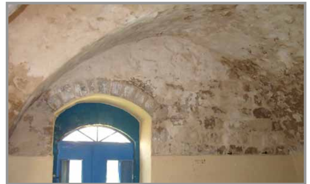
מפלס A. ציפוי בטון על כל פני הקמרון והקירות
