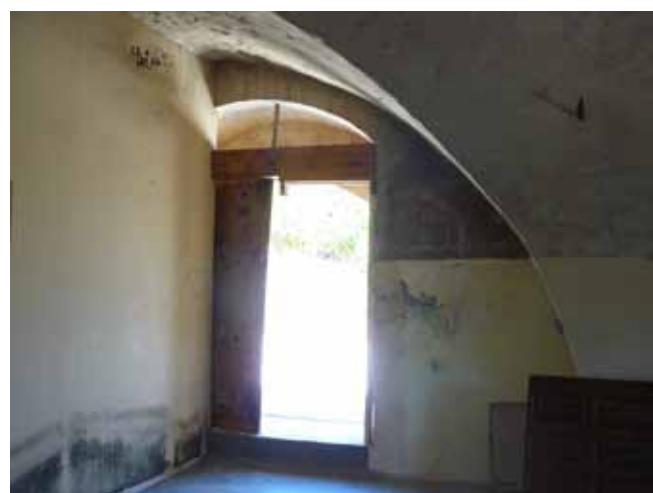
תוספת קירות גבס בחלוקות פנים. רצפת בטון מוחלק (תוספת מאוחרת).
