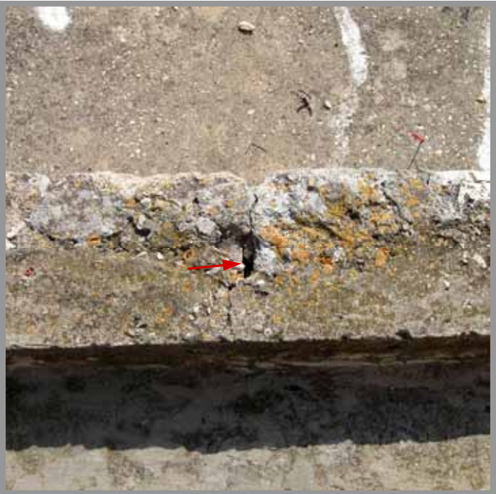
סדקים בקופינג הקיר מאפשרים חדירת מי הגשמים לעומק הקירות, האומנות ולמילוי הקמרונות.
