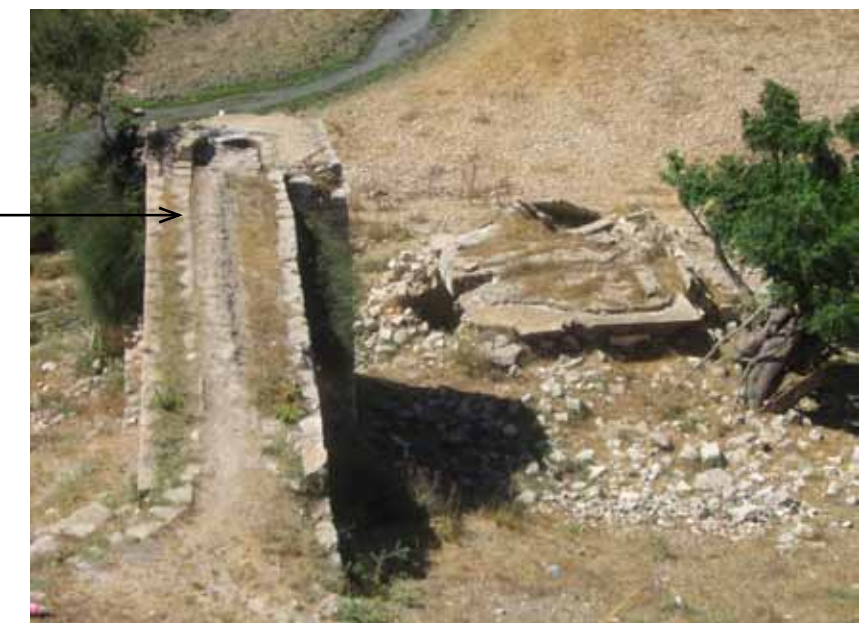
תעלת המים המובילה מים מטחנת הנזירים לטחנות מרפוקה
