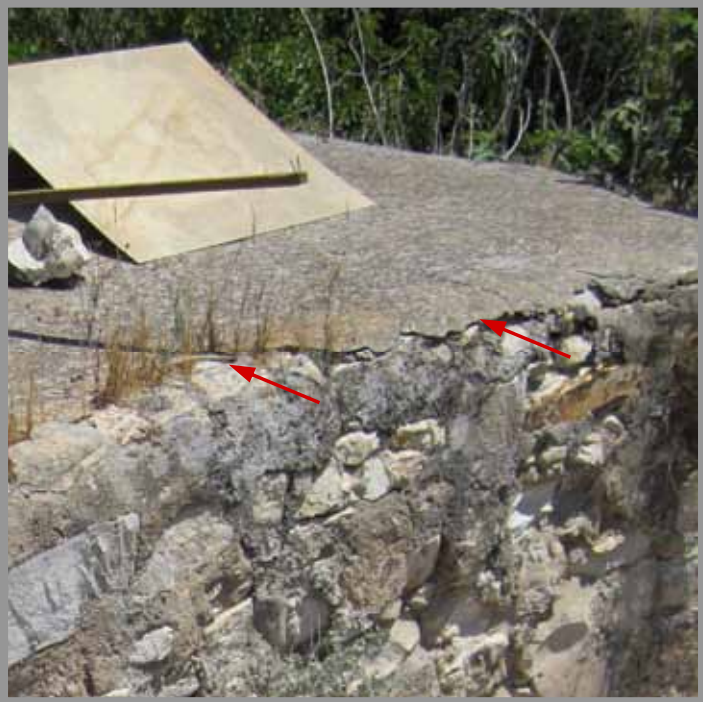
מפלס D, גג המבנה שנושא את התעלה העליונה. איטום הבטון נסדק, צמחייה בסדקים.
