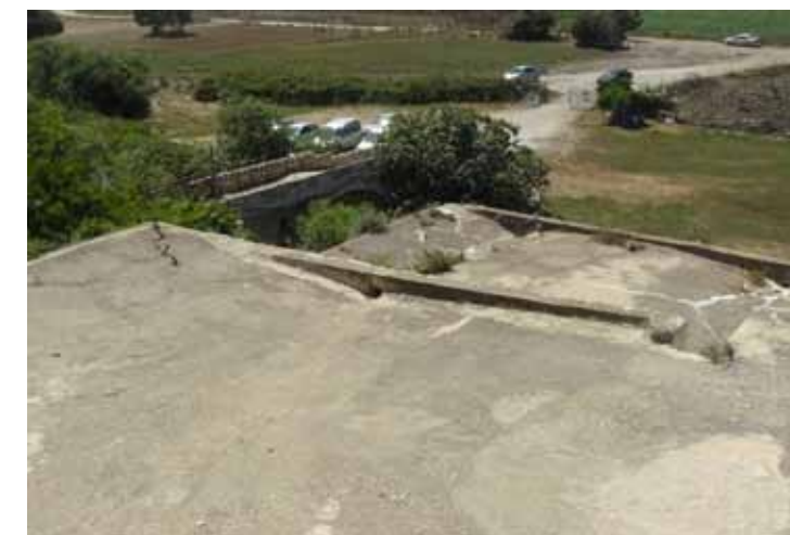
יציקת בטון על גג מפלסים A ו-B, ככל הנראה תוספת מאוחרת. אביצור בשנות ה-50 מתעד את תעלות המים המובילות את המים אל הארובות של הטחנה התחתונה. הוא מתאר אותן עוברות על גבי גג מפלס B ורוחבן 60 ס"מ. כמו כן מתאר את פתחי הארובות (60 ס"מ). כיום לא רואים את התעלות כלל, ככל הנראה מוסתרות על ידי יציקת הבטון של הגג. ישנו פתח שככל הנראה הינו שריד לפתח הארובה הדרומית.
