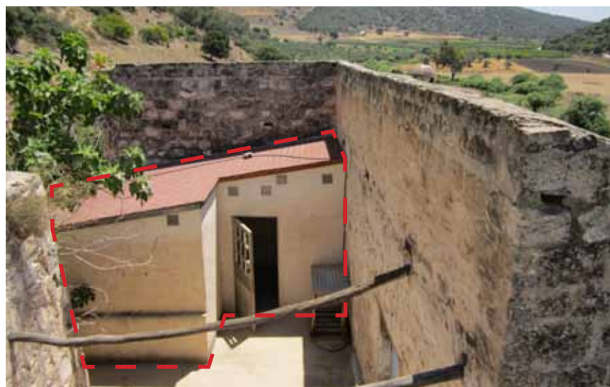
הרחבת מפלס D על ידי תוספת מבניה קלה (גבס ועץ).
