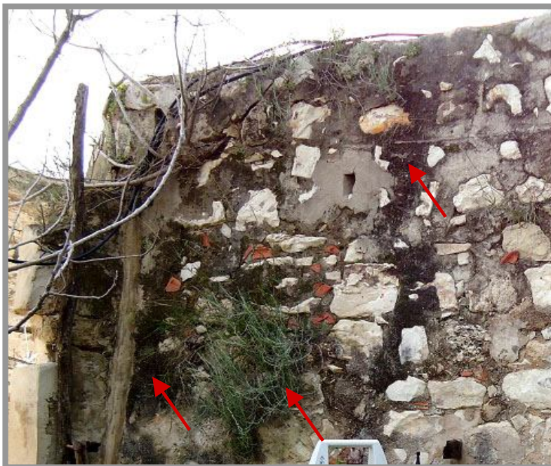
קיר התעלה העליונה. רטיבות גבוהה מאוד, עובש וצמחייה על פני הקיר.
