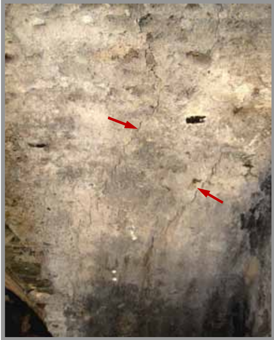
בעיה 2. מפלס C. סדקים בקמרון צלב. החלק הימני של הקמרון נשען על האומנה, והחלק השמאלי נשען על צלע הקמרון.
