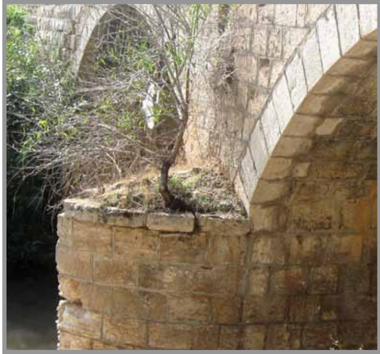
בעיה 18. חוסר שכבת ההגנה והאיטום על המשטח האופקי של אומנת הגשר, מי הגשמים מחלחלים לתוך האומנה. צמחייה השתרשה בליבת האומנה.
