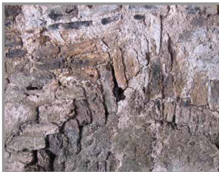
בעיה 9א. מפלס C. חומר מליטה חלש ומתפורר בקמרון, מישקים ריקים.
