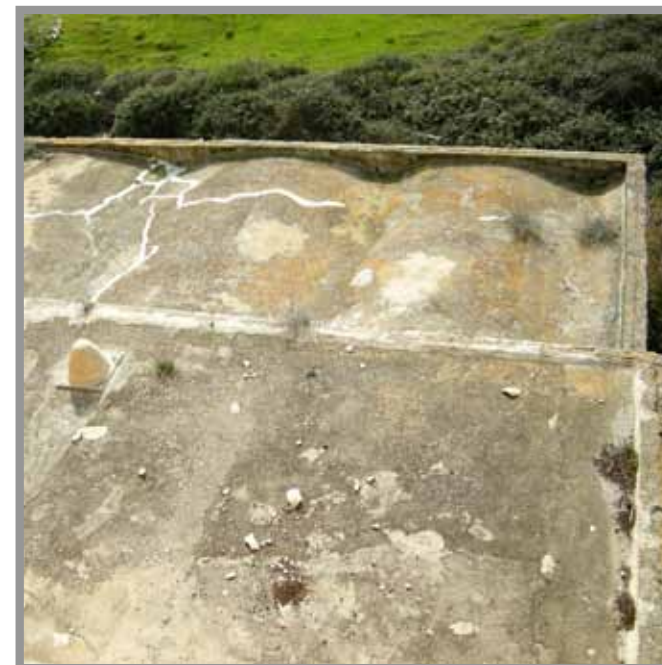
מפלס A, חזית דרומית. מסומנים קווי הקמרונות בחלל פנימי. תהליך הבלייה חמור יותר על פני קירות המסך מתחת לקמרונות, בגבם ישנה שכבת הבטון (ראו חתכים)
