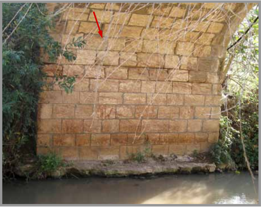
מצב אומנת הגשר. ניתן לראות שמצב האבן בסמוך לנחל סביר, אך קיימת בלייה במפלס "חיק" הקשת, הדבר מצביע על כך שחלחול מי הגשמים מהמשטח העליון הרסני יותר מהשפעת מי הנחל.
