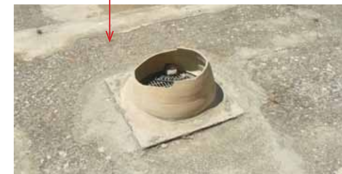
יציקת בטון על גג מפלסים A ו-B, ככל הנראה תוספת מאוחרת. אביצור בשנות ה-50 מתעד את תעלות המים המובילות את המים אל הארובות של הטחנה התחתונה. הוא מתאר אותן עוברות על גבי גג מפלס B ורוחבן 60 ס"מ. כמו כן מתאר את פתחי הארובות (60 ס"מ). כיום לא רואים את התעלות כלל, ככל הנראה מוסתרות על ידי יציקת הבטון של הגג. ישנו פתח שככל הנראה הינו שריד לפתח הארובה הדרומית.
