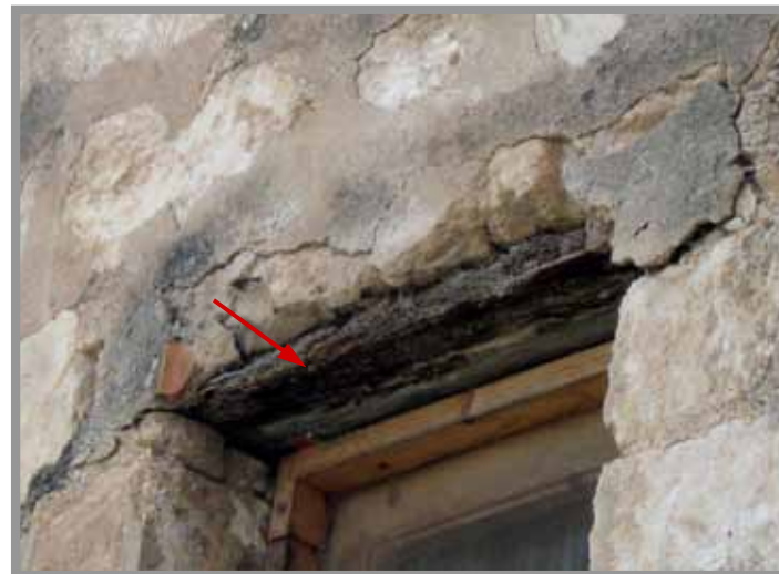
בעיה 13. מפלס D, קורת המשקוף נרקבה. מבט מהחזית המזרחית
