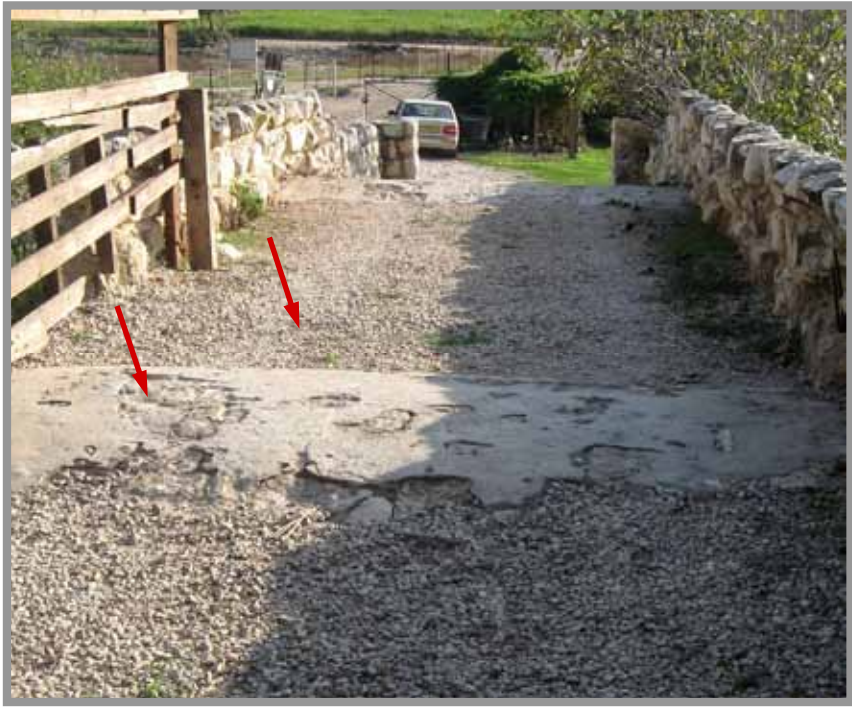
חוסר שכבת הגנה ואיטום במעבר הגשר, מי הגשמים מחלחלים לתוך הקשתות ומילוי "חיקי" הקשתות
