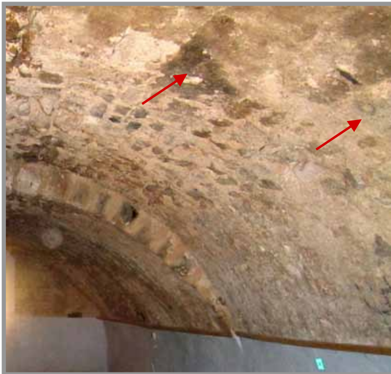
קמרון במפלס B. רטיבות גבוהה מאוד, ירוקת על פני הקמרון.
