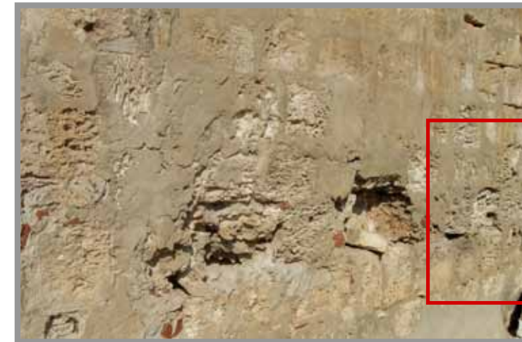
בעיה 9ב. מפלס הכוכים, חזית דרומית. מילוי מישקים בבטון, החמרת בליית האבן באזור בו הייתה רטיבות גבוהה.
