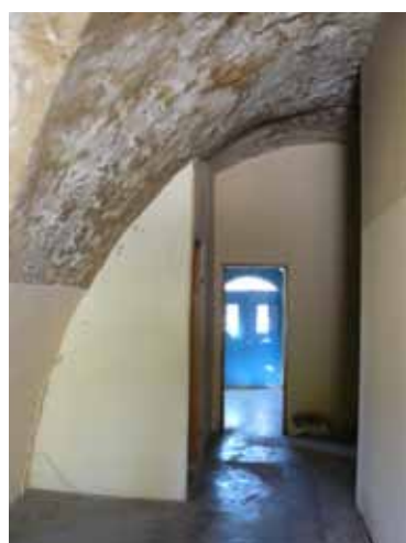
הרחבת מפלס D על ידי תוספת מבניה קלה (גבס ועץ).
