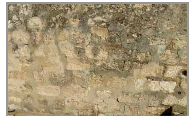
בעיה 9א. מפלס D, חזית מערבית. מילוי מישקים בבטון, יתכן שהבעיה בלתי הפיכה – לא ניתן יהיה להסיר בטון ללא פגיעה באבן מקורית.
