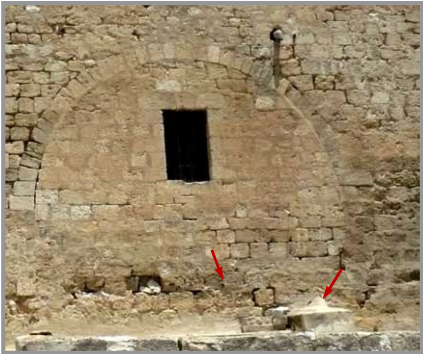
בעיה 3. מפלס C, חזית דרומית. נטיית קטע הקיר, בתשתית של הקטע הנטוי קימת בלייה חמורה של האבנים ושל חומר המליטה. בסמוך נמצאים פיר מים ותעלה סגורה.
