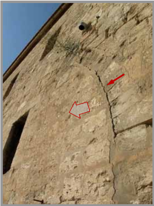
בעיה 3. מפלס C, חזית דרומית. נטיית קטע הקיר, סדר המפריד את הקטע הנטוי.
